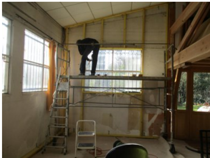
photo 3 - Installation de l'ossature en bois sur le mur ouest du local.
