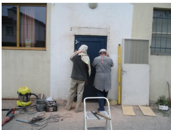
Photo 16 - Pose de la nouvelle porte, à droite l'ancienne.
