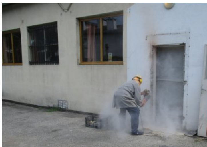
Photo 14 - Un gilet jaune ? Modification du cadre pour accueillir la nouvelle porte d'entrée.
