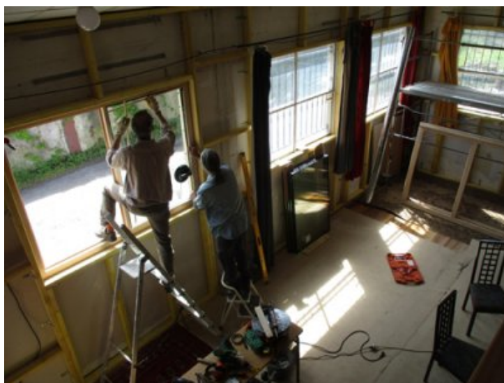
Photo 7 - Pose de la première fenêtre en bois et des vitres sécurit.
