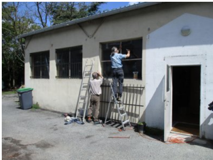
Photo 6 - Descellement et abattage de l'ancienne fenêtre
