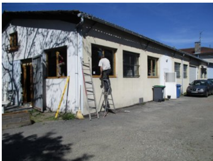
Photo 7 - Pose de la première fenêtre en bois et des vitres sécurit.
