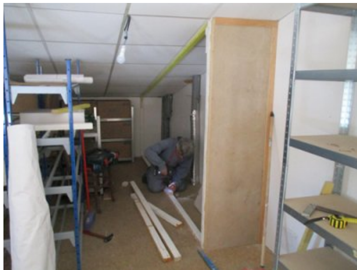
photo 1- Mezzanine - Placard-débarras pour la VMC, chauffe-eau, outils...
