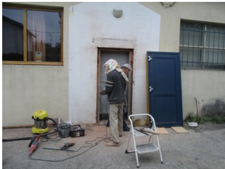
Photo 15 - L'emplacement pour la porte est en voie d'être terminé. Rien n'est simple...
