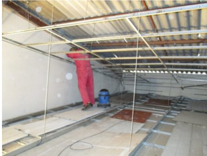
Photos 7 - Août - Dépoussiérage avant isolation
