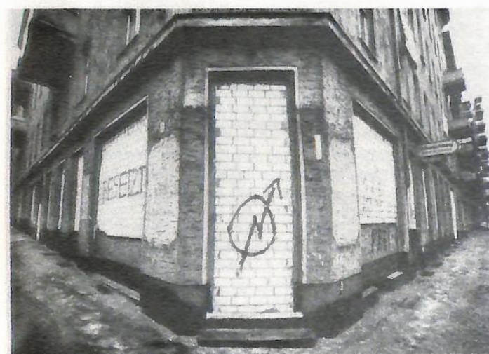
1 - Sigle des squatters sur les portes murées depuis la création du mur.
