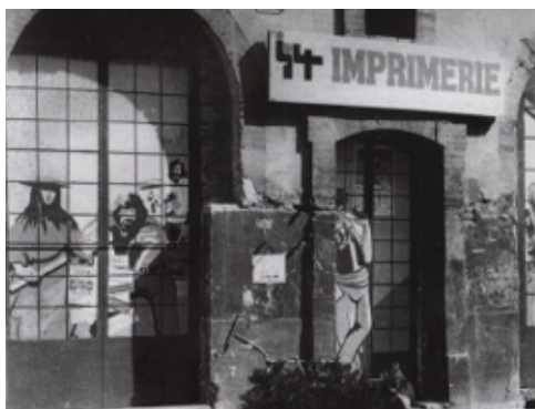
Façade de l'imprimerie après une réparation rapide et sommaire
